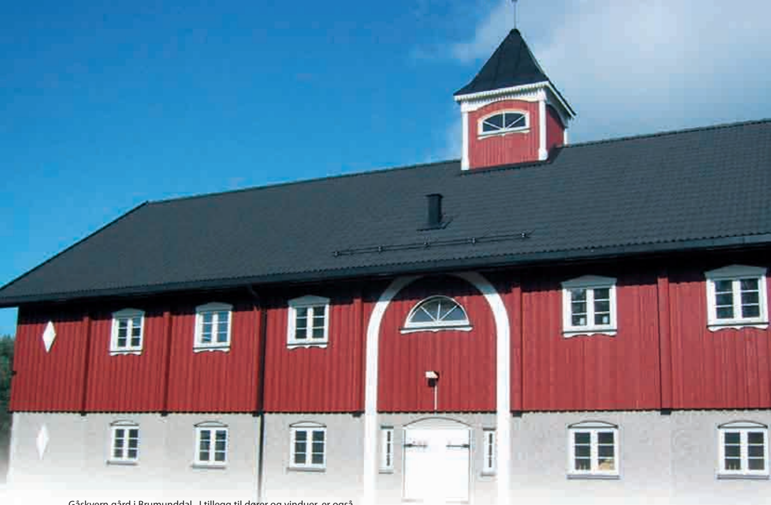
Gåskvern gård i Brumunddal. I tillegg til dører og vinduer, er også limtrebuen over inngangspartiet produsert på fabrikk.
